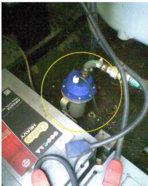
Zdj. Nr 1 Grzałka podgrzewu bloku silnika
